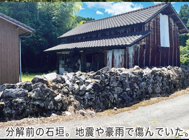
分解前の石垣。地震や豪雨で傷んでいた。
