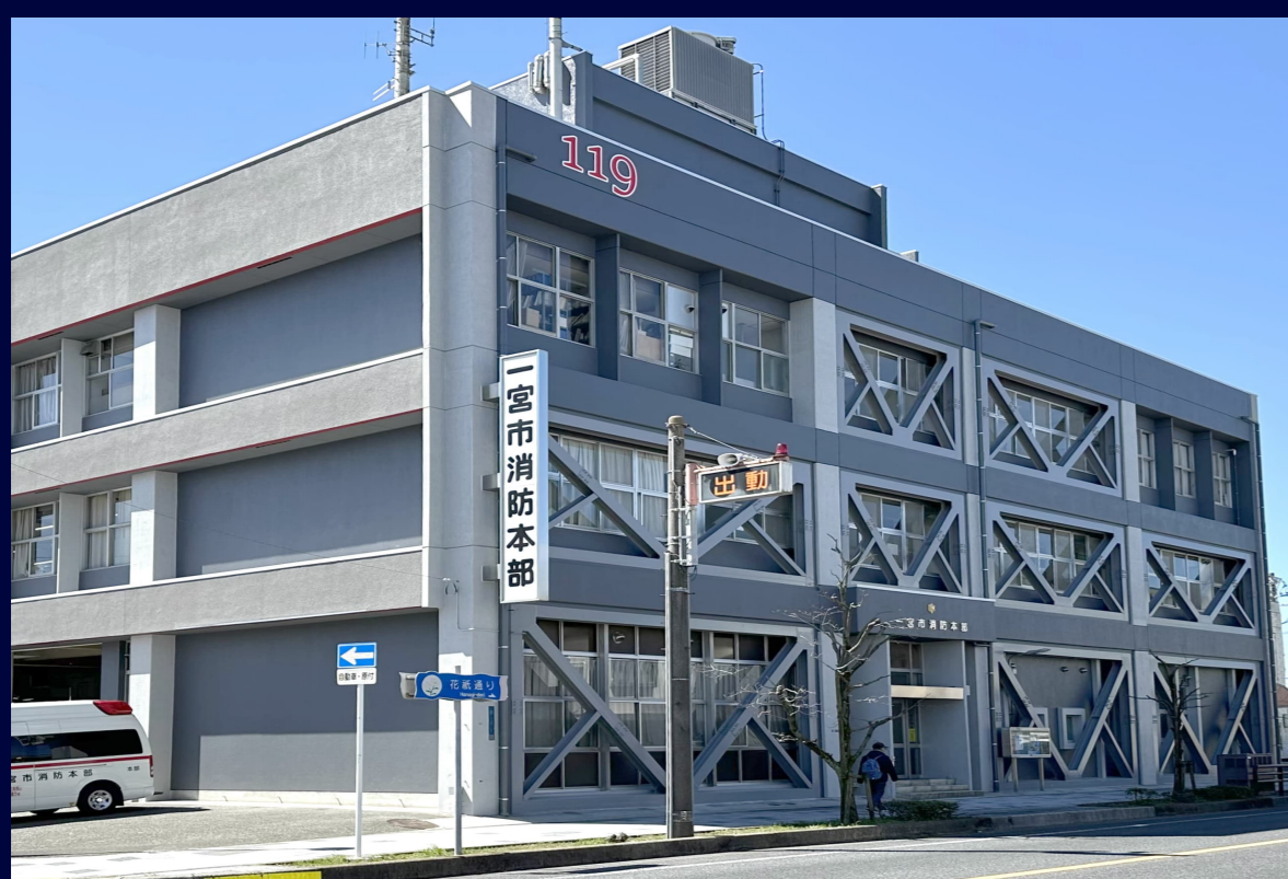
一宮市消防本部外壁塗装
