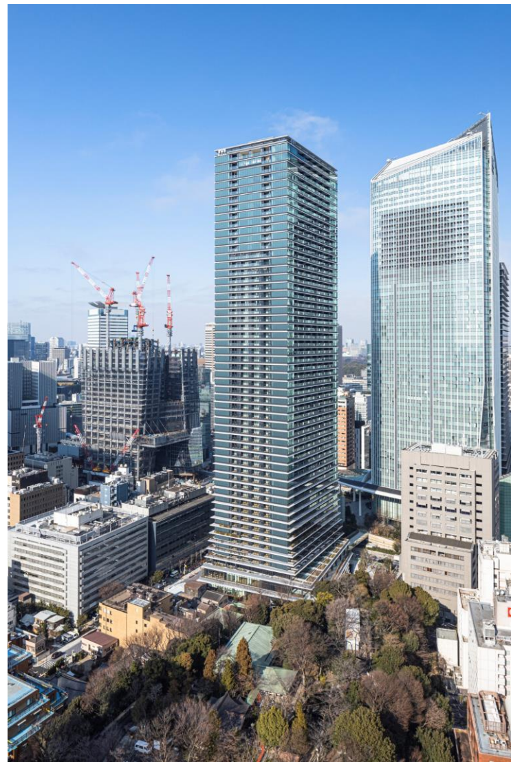
虎ノ門ヒルズレジデンシャルタワー
